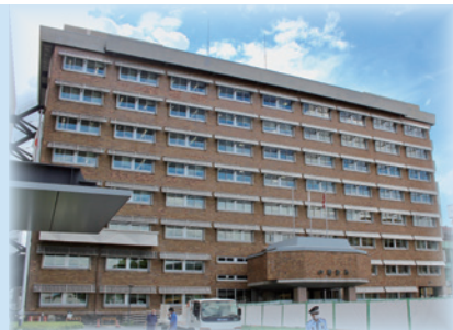
山梨県庁 本館
