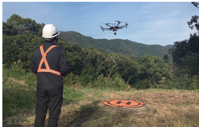
ドローンの計測状況
