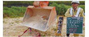
ICT施工前にバケット精度確認
