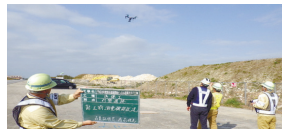
ドローンによる起工測量
