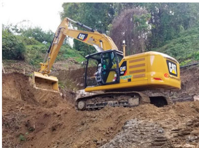
MCによる施工 (令和元年度 機能強化・老朽化対策事業第7号工事)
