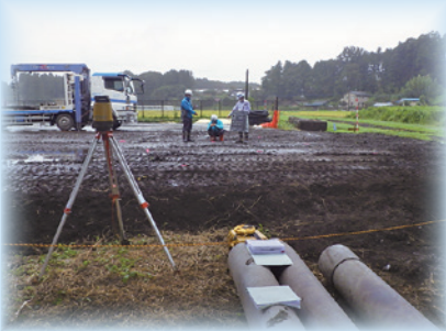
3次元測量を活用し打杭位置確認
