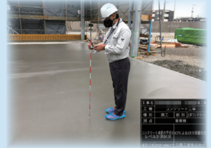
3次元測量によるコンクリート床の精度管理
