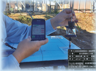
3次元測量によるアンカーボルトの据付精度管理
