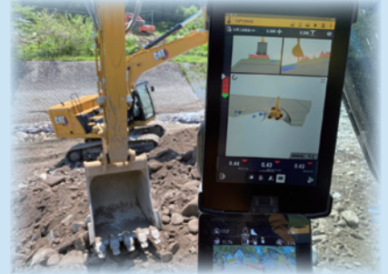
3Dモデルの通りに重機で施工
