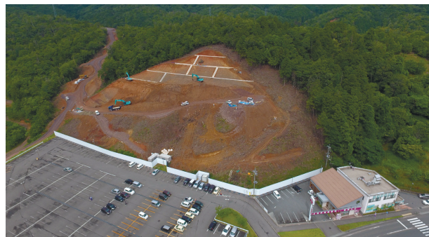
T病院駐車場整備工事の現場（ドローンによる空撮）
