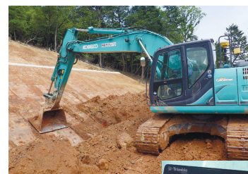
ICT建機による施工の模様
