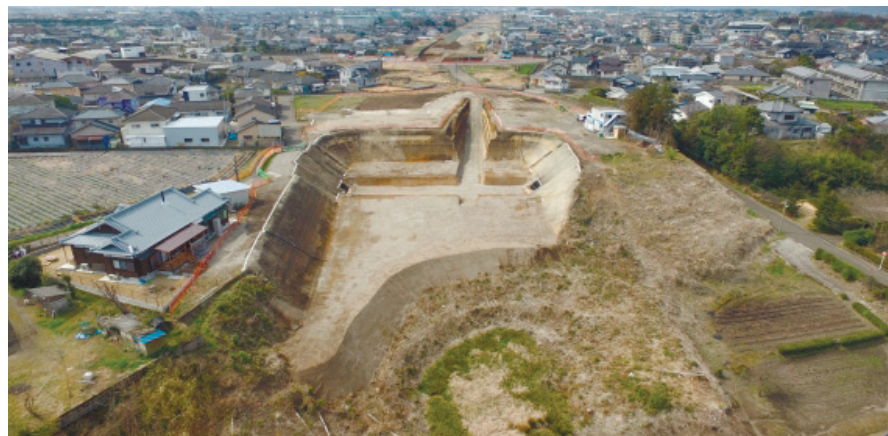
「宮崎10号南横市地区 跨道橋下部工(その2)外工事」現場
