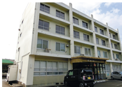
富岡建設本社（日南市）
