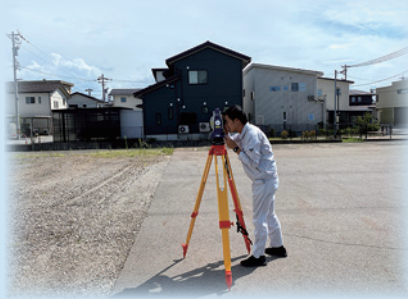
現地での測量作業
