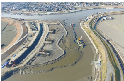
「矢部川徳島地区護岸設置外工事」現場写真
