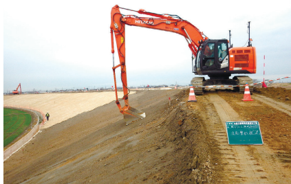
MCによる法面整形 (矢部川徳島地区築堤外工事)
