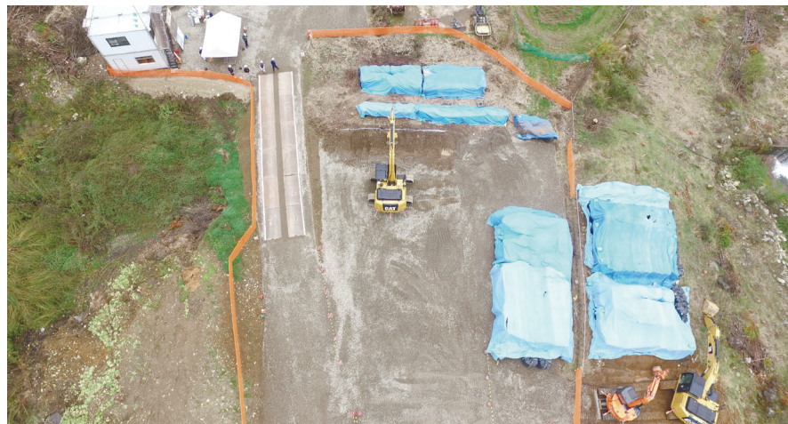
「居倉大深山地区 菅水路1号改修その1工事」現場
