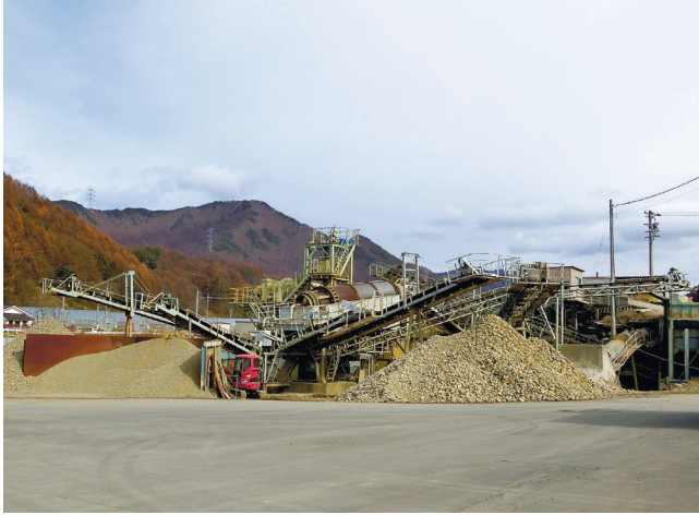
砕石プラント施設
