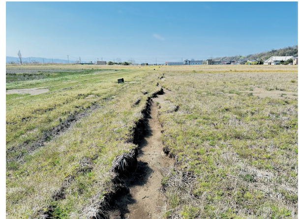
写真-1 田面の亀裂と噴砂
